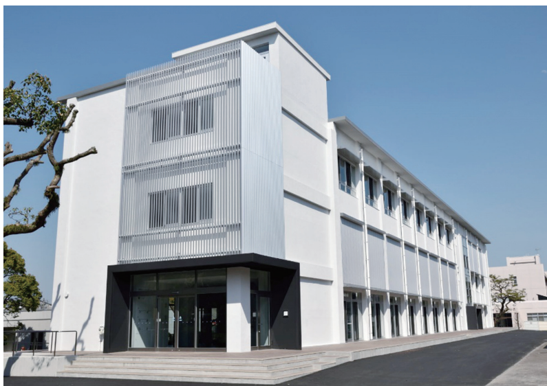
平成27年4月竣工「未来型インタラクティブ教育棟」
